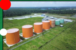
Tank Farm 2 x 3000 Ton CPKO 5 x 5000 Ton CPO
